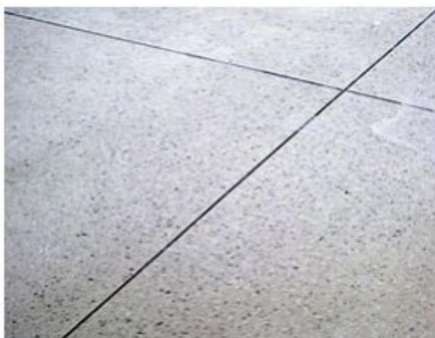
*Figura 4: Piso após acabamento com esmeril 180*
