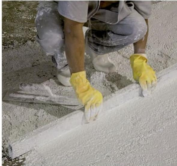
*Figura 2: Nivelamento com régua*
