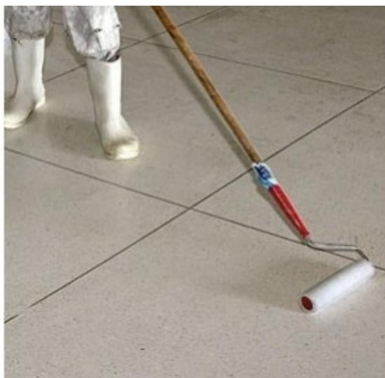
*Figura 5: Aplicação de selador para pisos*
